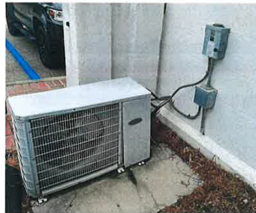
Elevator Machine Room Mini Split System
