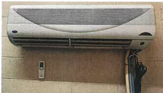
Elevator Machine Room Mini Split System
