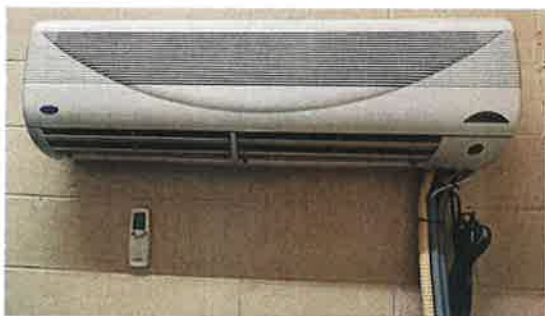
Elevator Machine Room Mini Split System
